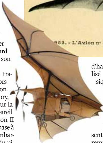
d'harmonie, un bois très léger utilisé pour les instruments de musique. Les membrures principales des ailes sont creuses, rigidifiées par de fines tiges de bois disposées transversalement à l'intérieur. Pour alléger l'ensemble au maximum, les quelques vis d'acier présentes sur l'Avion III sont évidées et remplies de bois de châtaignier.
